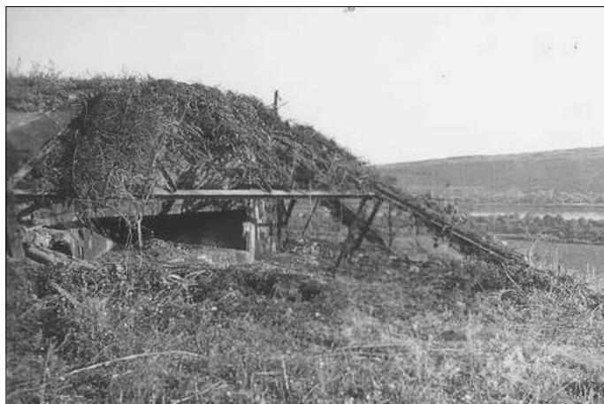
ДОТ № 247, II батальонный район. Роги, Дубоссары
