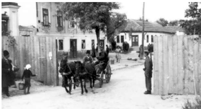
Вход в Кишинёвское гетто
