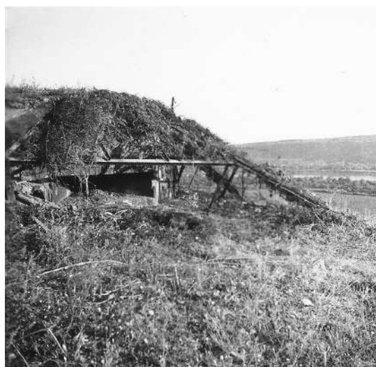
ДОТ 247, II батальонный район. Роги, Дубоссары
